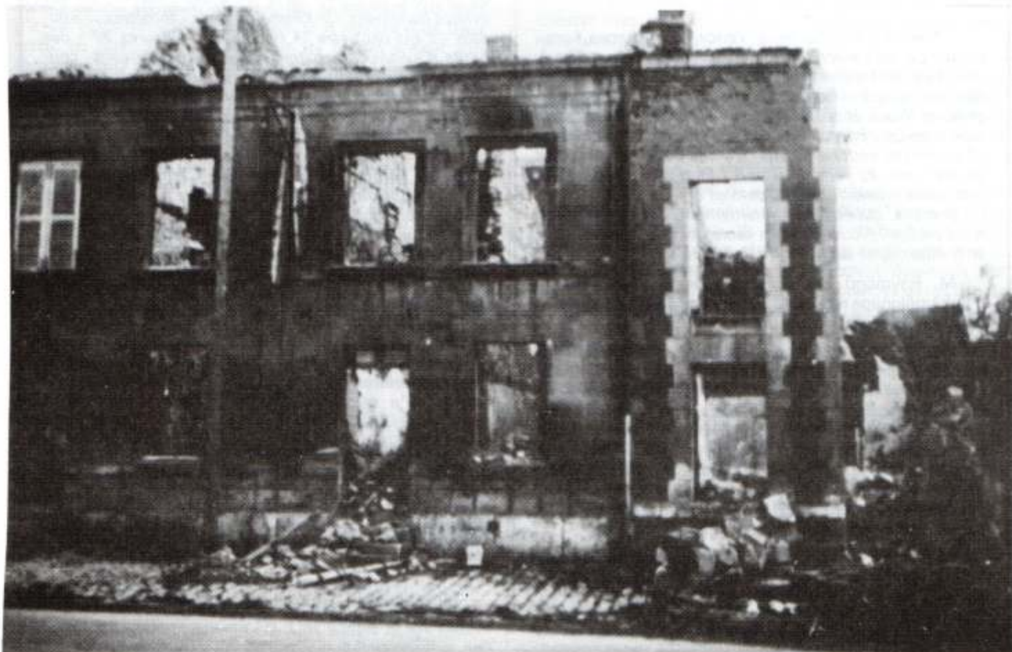
Maisons détruites en bordure de la route nationale - Photo : Mme Alice SATABIN.
