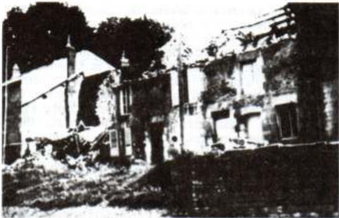
Non loin de l'église, les maisons Hureaux, Grivel et Chopin détruites le 12 mai.
