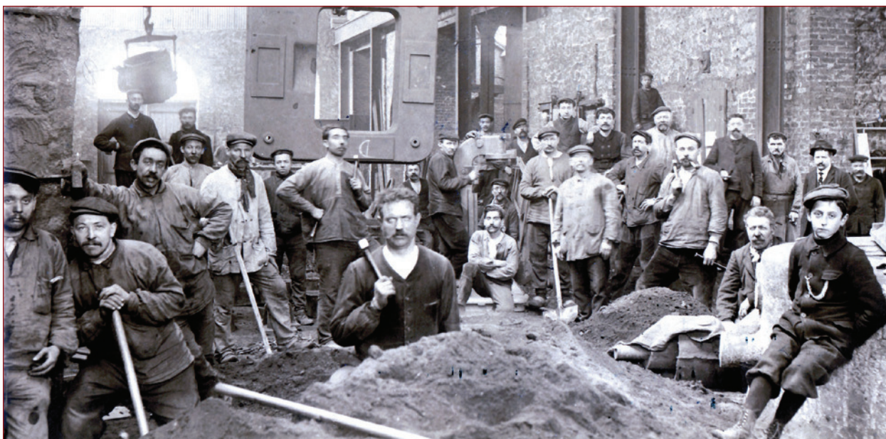
Fonderie ardennaise entre 1907 et 1921. Au premier plan, le tas de sable pour la confection des moules.
